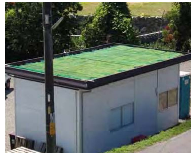
「藓苔基盤庭」を敷き詰めた伊賀市下柘植の事務所棟折板屋根の全景
